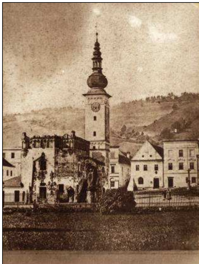
Fotografie z období krátce před demolicí.
